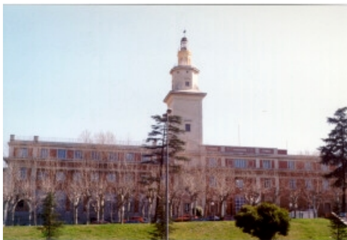
Figura 1.- Escuela Técnica Superior de Ingenieros Navales
